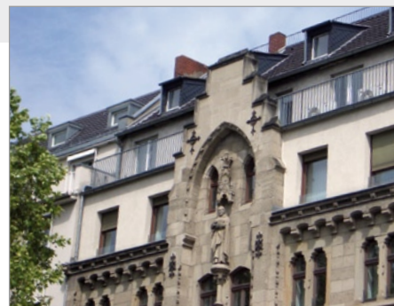
Erhalt der historischen Fassade
