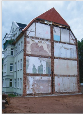
Gesicherte Giebelwand nach dem Abriss
