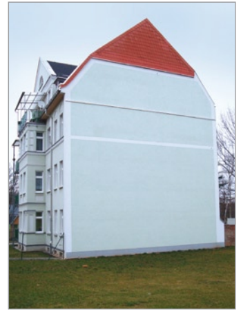
Giebelwand nach der Sanierung
