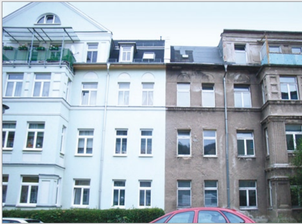
Fassade vor dem Abriss des Nebengebäudes
